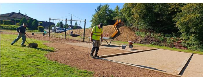
Les travaux se poursuivent à l'aire de jeux ! Avec l'assistance de Christian, Arnaud et Philippe, Jérôme et Clément ont réalisé la plateforme en béton qui accueillera une rampe métallique facilitant ainsi l'accès pour tous au toboggan. Des panneaux interdisant de fumer ainsi que l'accès aux chiens ont également été posés à l'entrée du site.
